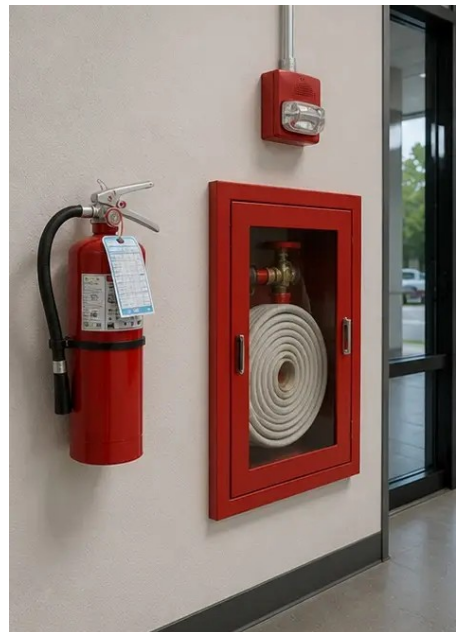
Photo #12. Echipamentul de siguranță inspectat și înregistrat
