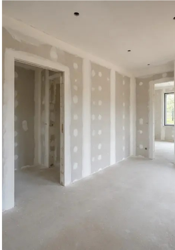
Foto nr.11 Lucrări de finisare a pereților interiori în curs
