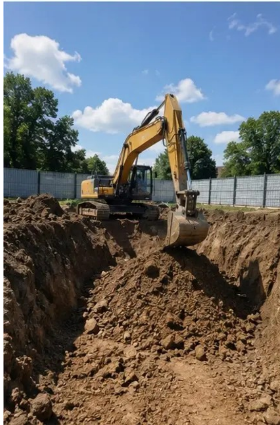
Foto nr.2 Săpături executate conform cerințelor proiectului
