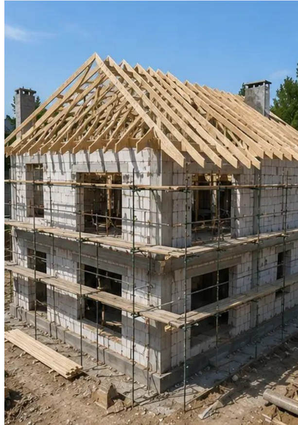
Foto nr.8 Lucrările de instalare a acoperișului finalizate
