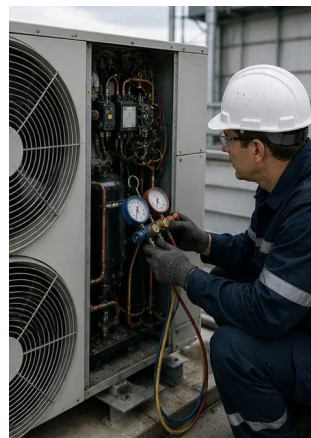
Foto nº6. Estado do equipamento de AVAC documentado
