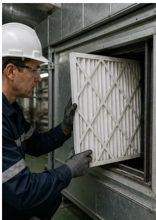
Foto nº7. Substituição do filtro de ar concluída
