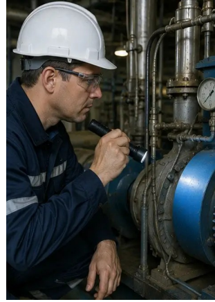
Foto nº2. Inspeção do equipamento mecânico concluída
