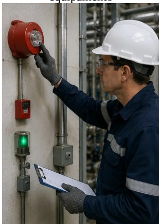
Foto nº13. Inspeção do sistema de segurança concluída
