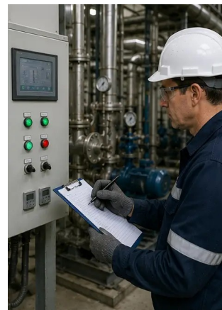
Foto nº14. Verificação final da manutenção realizada
