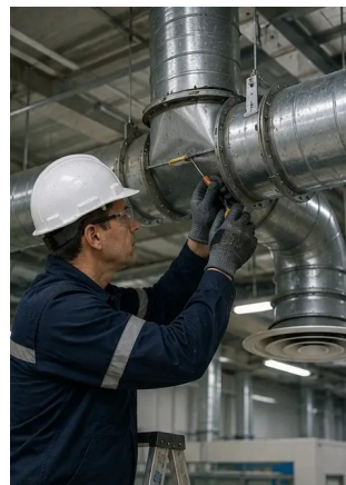
Foto nº8. Manutenção do sistema de ventilação concluída
