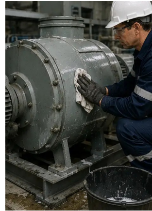
Foto nº12. Procedimento de limpeza do equipamento concluído
