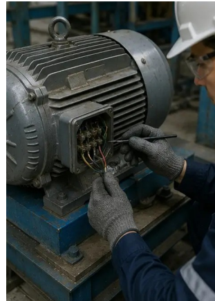
Foto nº4. Inspeção do motor elétrico concluída
