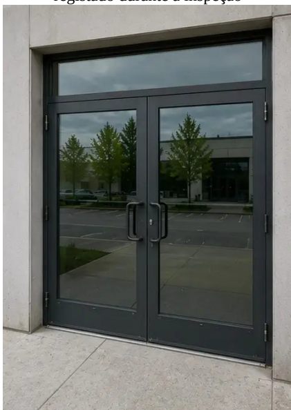
Photo #7. Estado das portas inspecionado e registado
