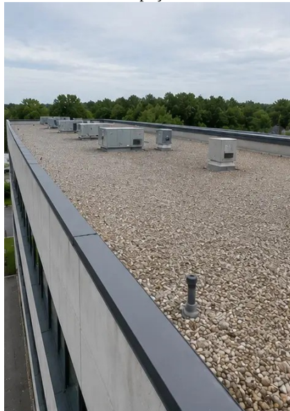
Photo #5. Inspeção do estado do telhado concluída
