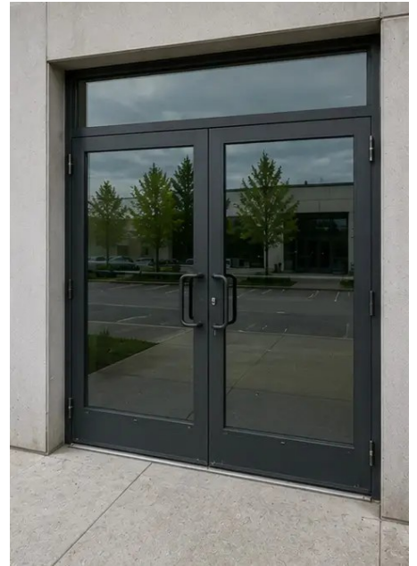
Photo #7. Estado das portas inspecionado e registado
