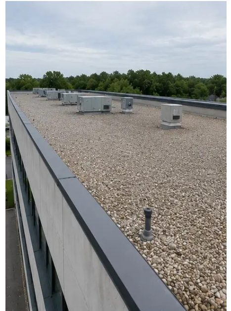
Photo #5. Inspeção do estado do telhado concluída
