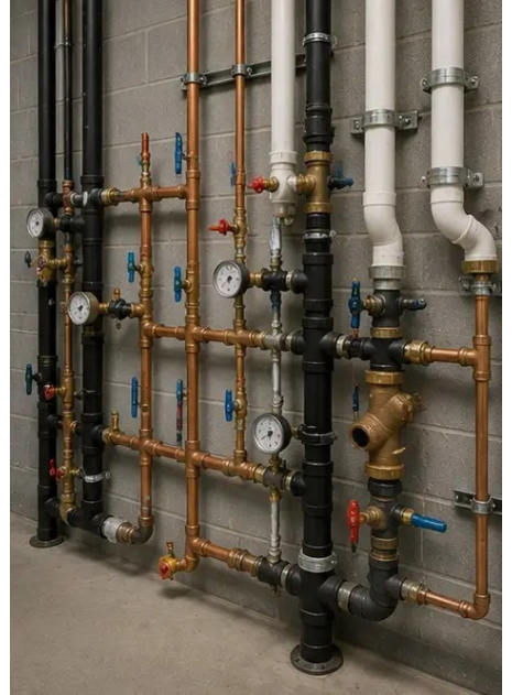
Photo #10. Inspeção do sistema hidráulico concluída
