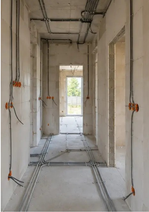
Foto n°9 Instalação dos sistemas elétricos em andamento
