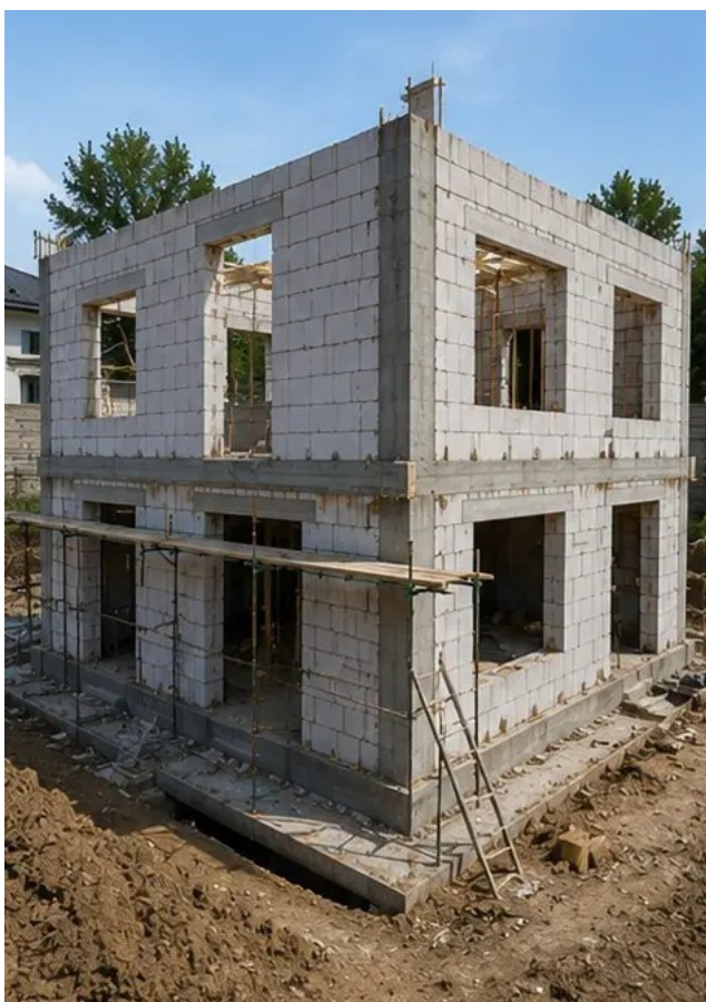
Foto nº7 Construção das paredes exteriores concluída para a secção do edifício
