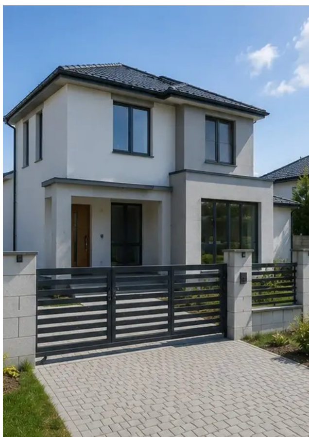
Foto nº15 Exterior do edifício concluído após a construção
