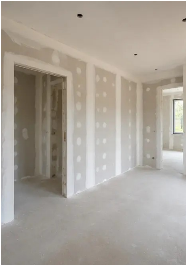
Foto n°11 Trabalhos de acabamento das paredes interiores em andamento
