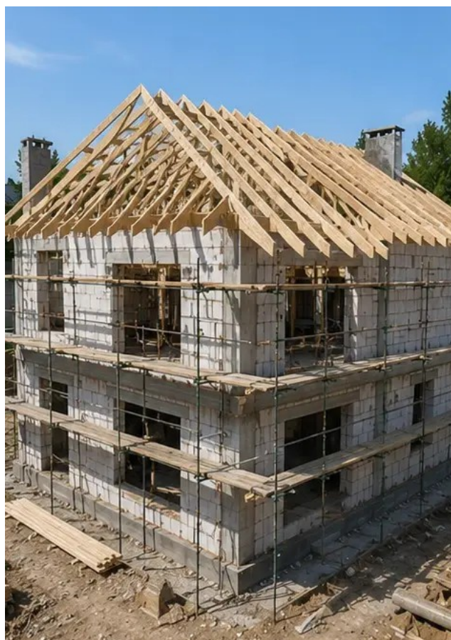
Foto nº8 Instalação da cobertura concluída
