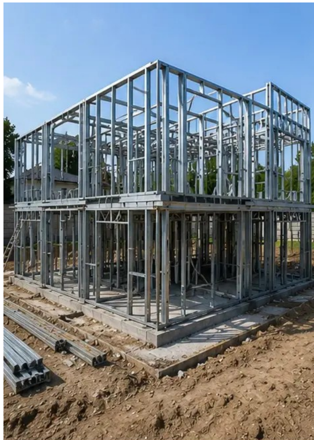
Foto nº6 Montagem da estrutura portante em andamento
