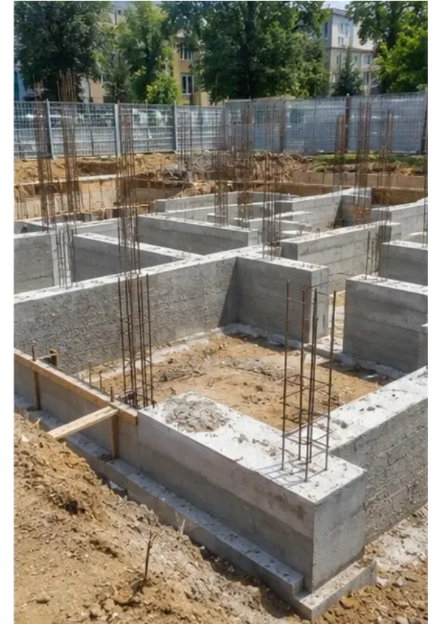
Foto nº3 Construção das fundações em andamento
