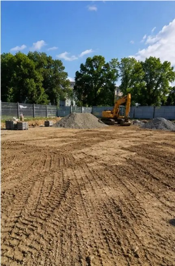
Foto nº1 Trabalhos de preparação do local concluídos antes do início da construção
