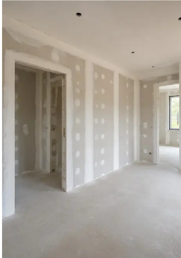
Foto nº11 Trabalhos de acabamento das paredes interiores em andamento
