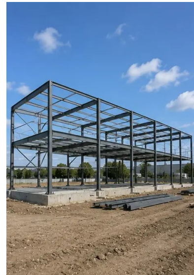
Foto n°7. Construção da estrutura portante em andamento
