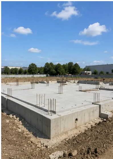
Foto n°5. Construção das fundações concluída
