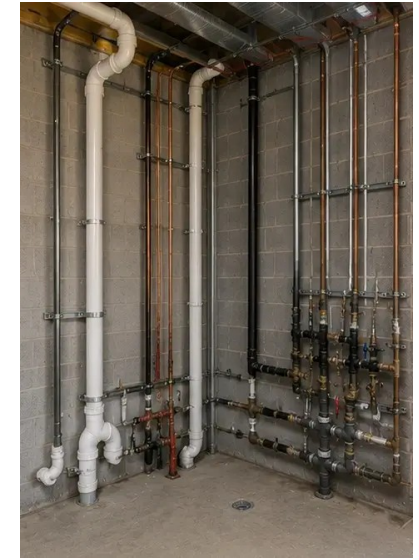
Foto nº12. Instalação dos sistemas hidráulicos concluída
