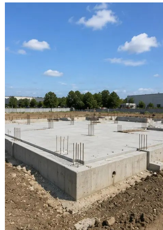
Foto nº5. Construção das fundações concluída
