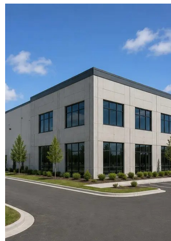
Foto nº16. Projeto concluído pronto a funcionar
