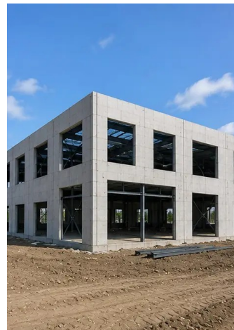
Foto nº9. Estrutura portante concluída de acordo com o cronograma do projeto
