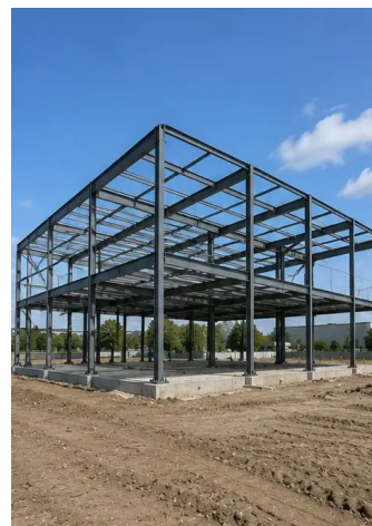
Foto nº8. Estrutura portante concluída de acordo com o cronograma do projeto
