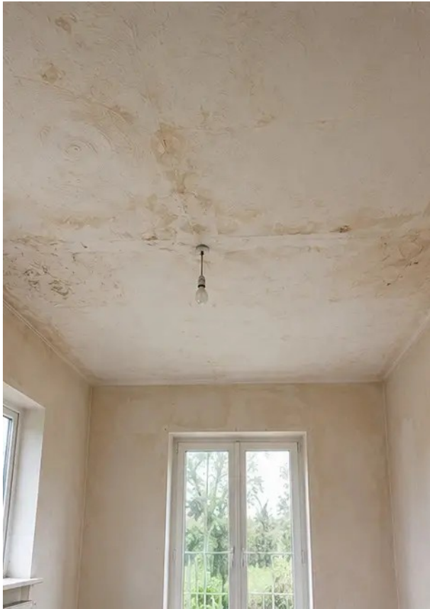
Foto n°7 Estado do teto antes da renovação
