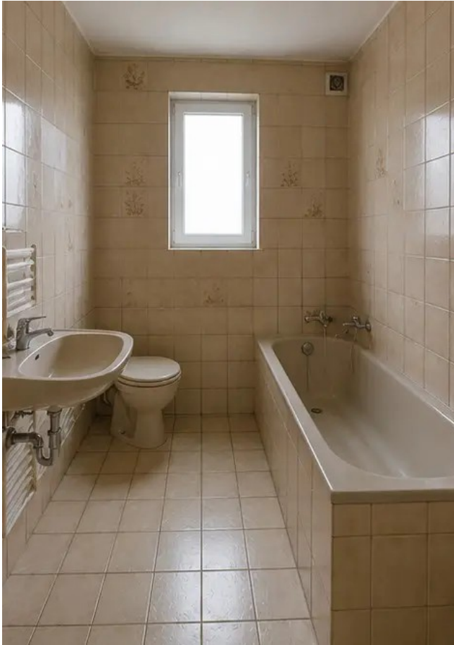
Foto nº9 Estado da casa de banho antes da renovação
