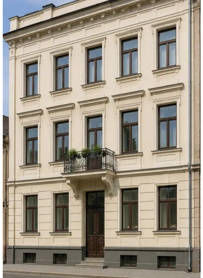
Foto nº14 Fachada do edifício depois dos trabalhos de restauro
