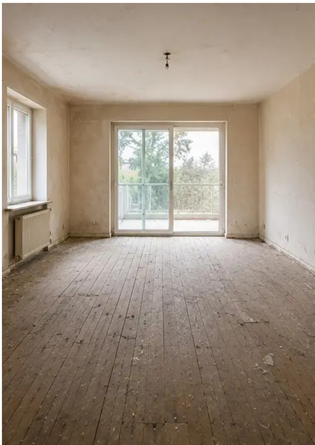
Foto n°1 Estado da sala de estar antes da renovação
