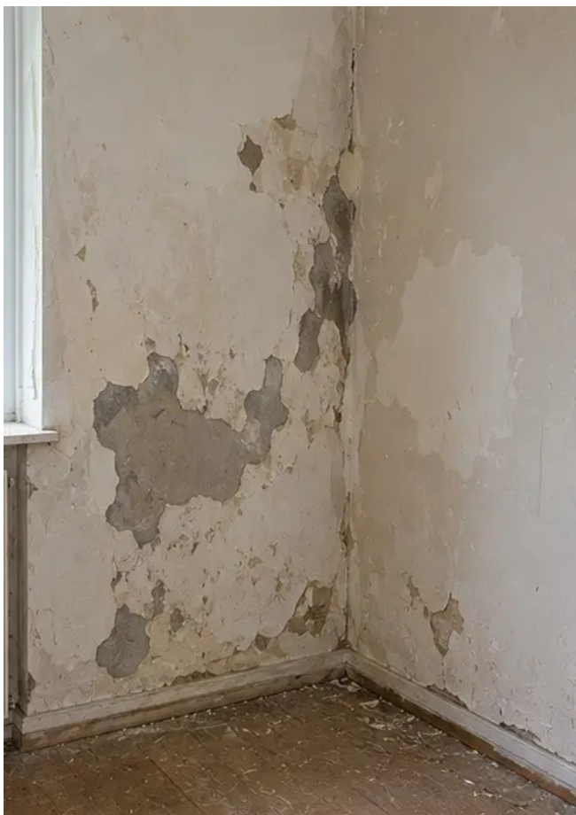
Foto n°3 Estado da parede antes dos trabalhos de reparação
