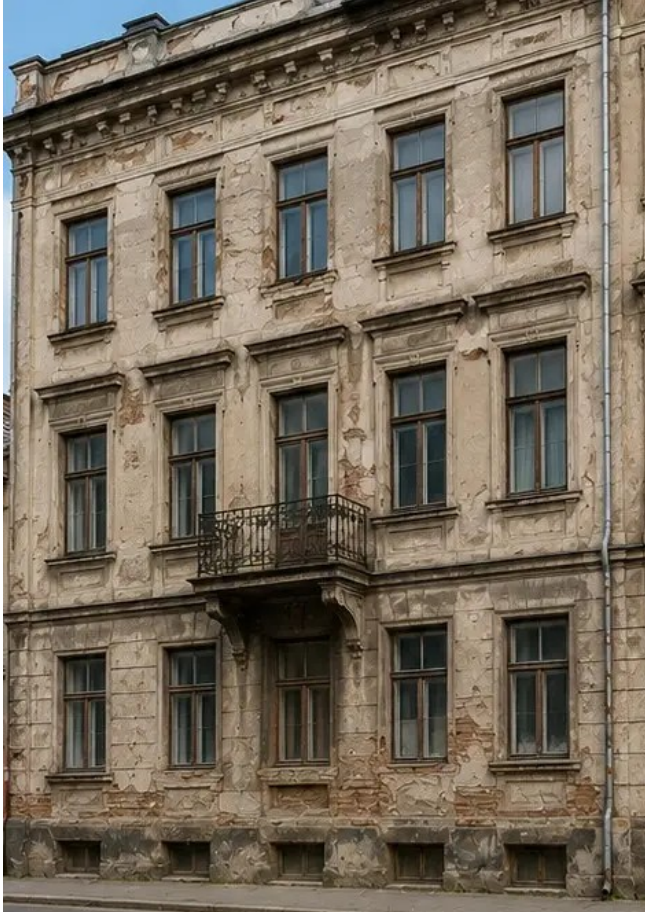
Foto nº13 Fachada do edifício antes dos trabalhos de restauro
