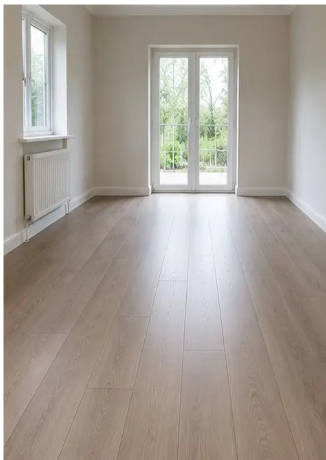
Foto n°6 Estado do pavimento depois da substituição
