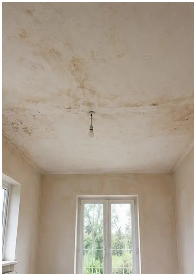
Foto n°7 Estado do teto antes da renovação
