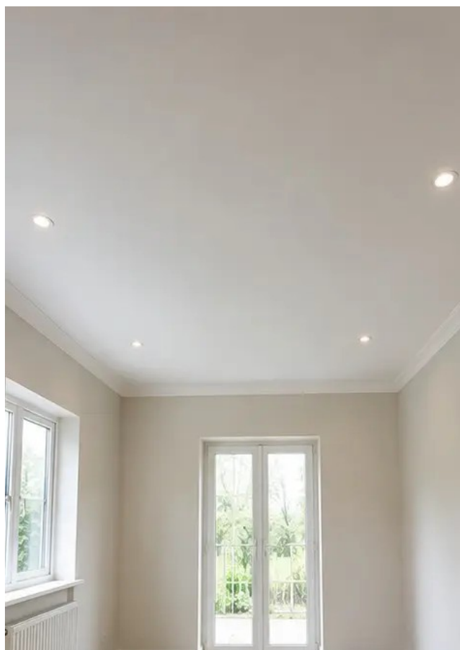
Foto n°8 Estado do teto depois da renovação
