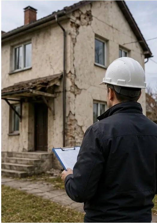
Foto n°16 Fotografia resumo final da inspeção de danos
