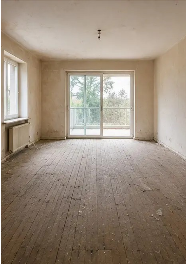
Dokumentacja fotograficzna №1 Stan salonu przed remontem
