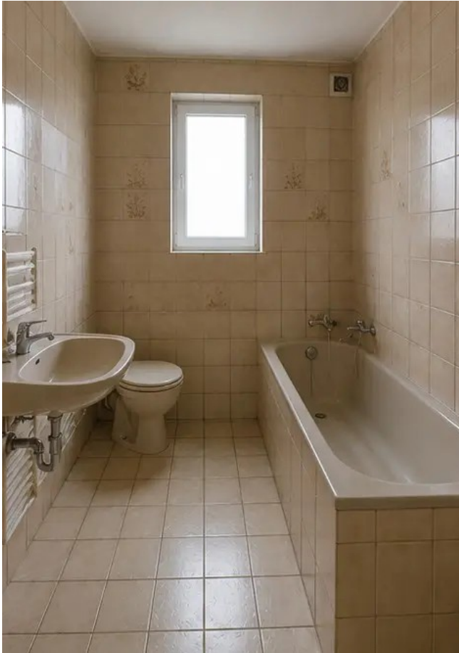
Dokumentacja fotograficzna №9 Stan łazienki przed remontem
