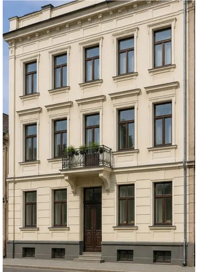
Dokumentacja fotograficzna №14 Fasada budynku po pracach renowacyjnych
