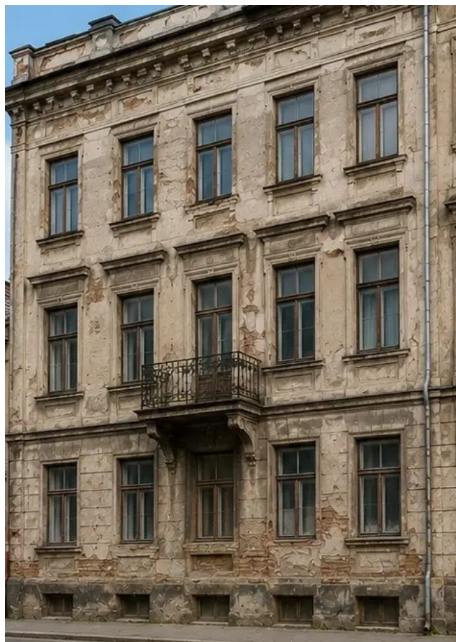
Dokumentacja fotograficzna №13 Fasada budynku przed pracami renowacyjnymi
