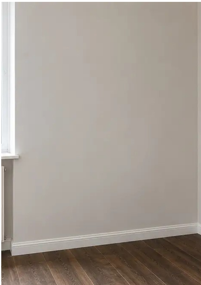
Dokumentacja fotograficzna №4 Stan ściany po naprawie
