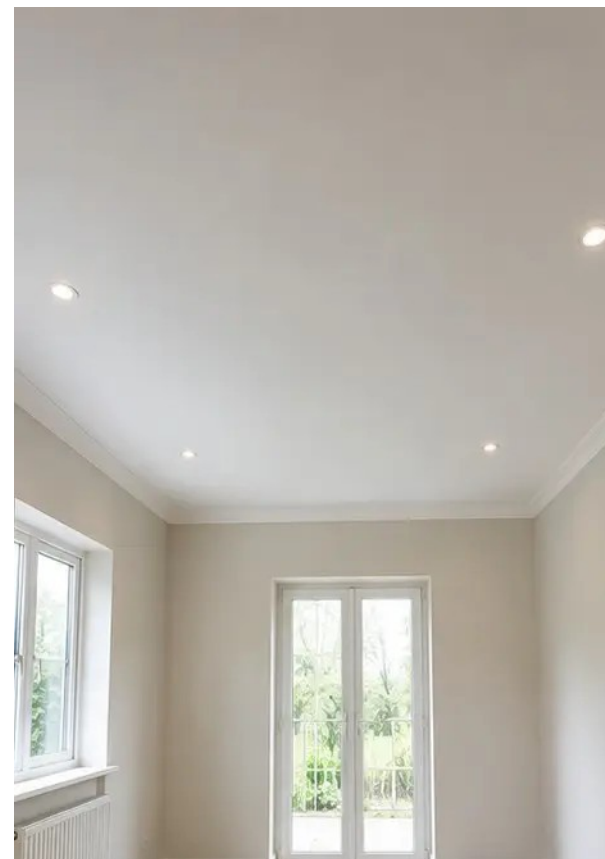
Dokumentacja fotograficzna №8 Stan sufitu po remoncie
