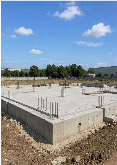
Dokumentacja fotograficzna №5. Fundamenty wykonane
