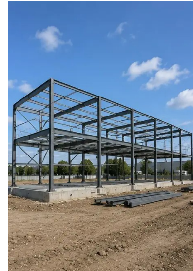
Dokumentacja fotograficzna №7. Budowa konstrukcji nośnej w toku
