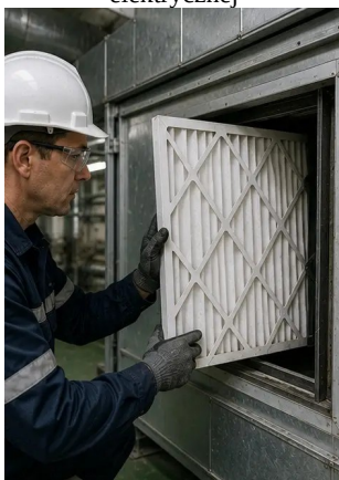
Dokumentacja fotograficzna №7. Wymiana filtra powietrza zakończona
