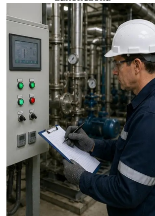
Dokumentacja fotograficzna №14. Końcowa weryfikacja konserwacji przeprowadzona
