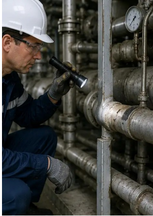
Dokumentacja fotograficzna №9. Inspekcja rur zakończona zgodnie z harmonogramem konserwacji
