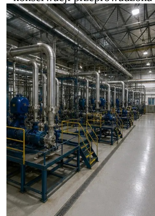
Dokumentacja fotograficzna №16. Ogólny przegląd obiektu po zakończeniu prac konserwacyjnych
