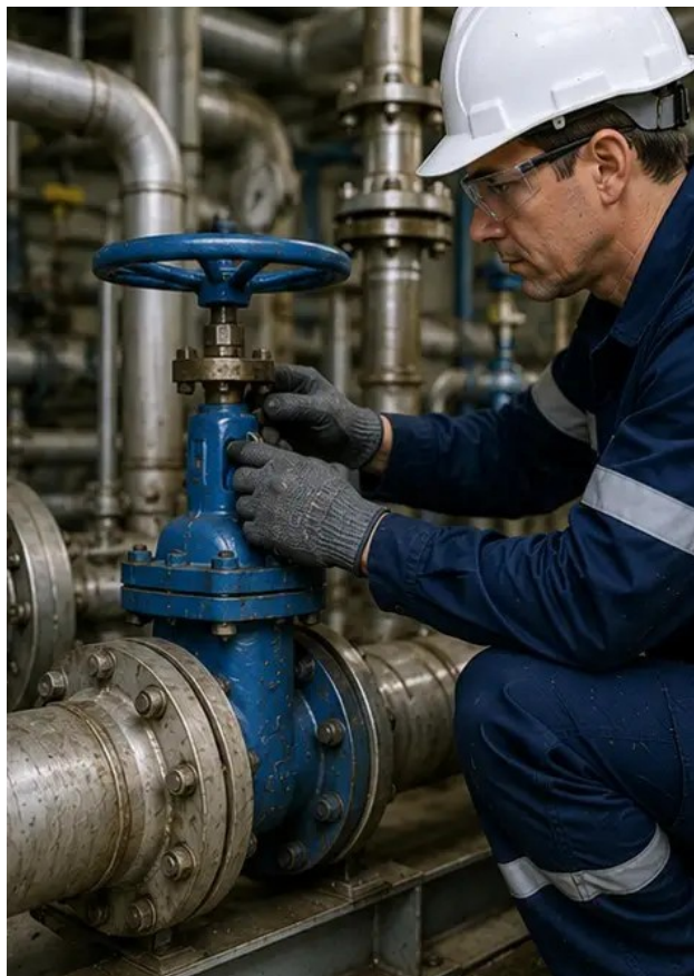
Dokumentacja fotograficzna №10. Stan zaworu oceniony podczas inspekcji
