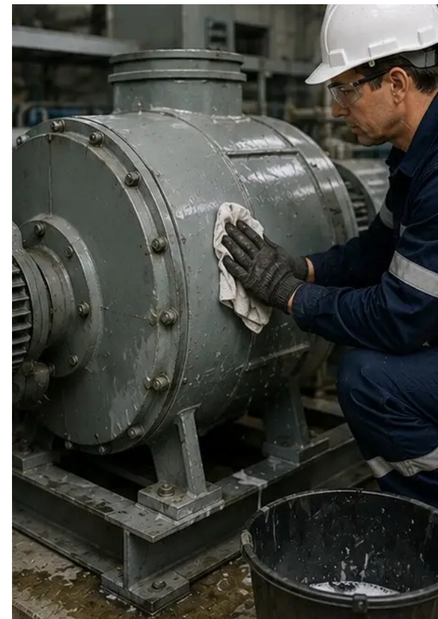
Dokumentacja fotograficzna №12. Procedura czyszczenia urządzeń zakończona
