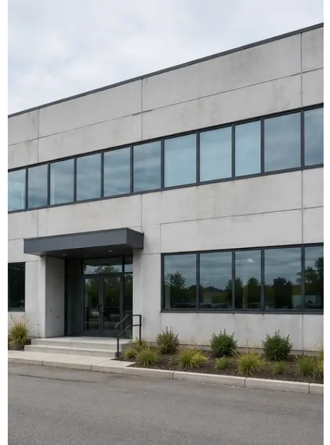
Photo #2. Stan elewacji frontowej podczas inspekcji
