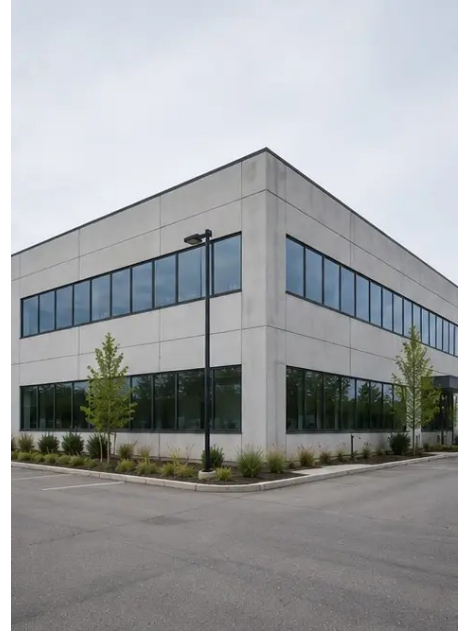
Photo #1. Ogólny widok skontrolowanej nieruchomości
