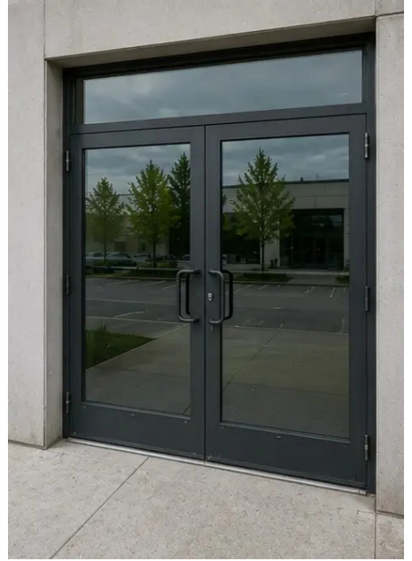
Photo #7. Stan drzwi skontrolowany i odnotowany
