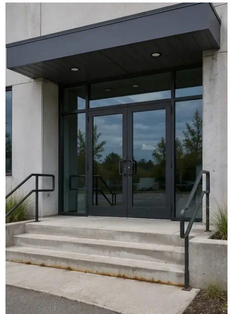
Photo #3. Obszar wejścia głównego skontrolowany i udokumentowany
