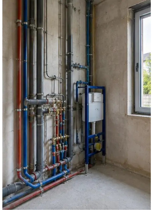
Dokumentacja fotograficzna №10 Instalacja systemów wodno-kanalizacyjnych zakończona w wyznaczonych strefach
