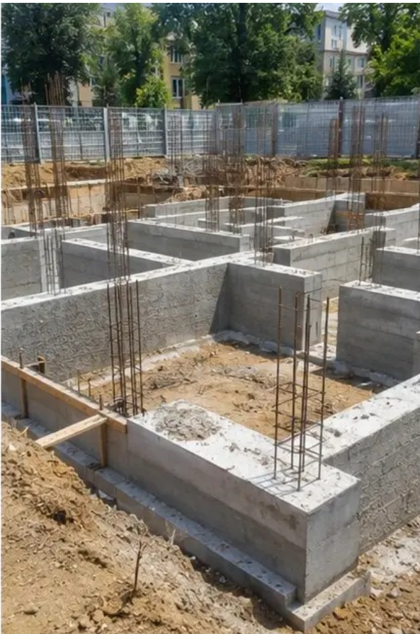
Dokumentacja fotograficzna №3 Wykonywanie fundamentów w toku
