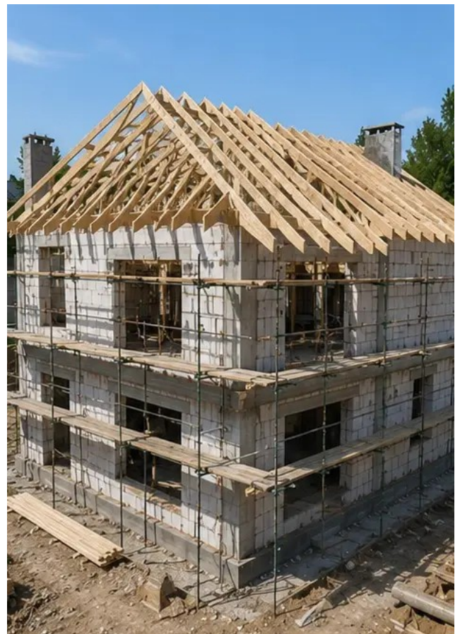
Dokumentacja fotograficzna №8 Prace montażowe dachu zakończone
