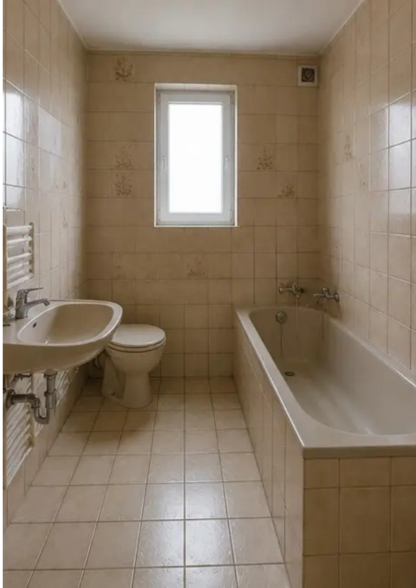
Foto №9 Staat van de badkamer voor de renovatie
