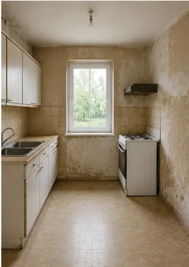
Foto №11 Staat van de keuken voor de renovatie
