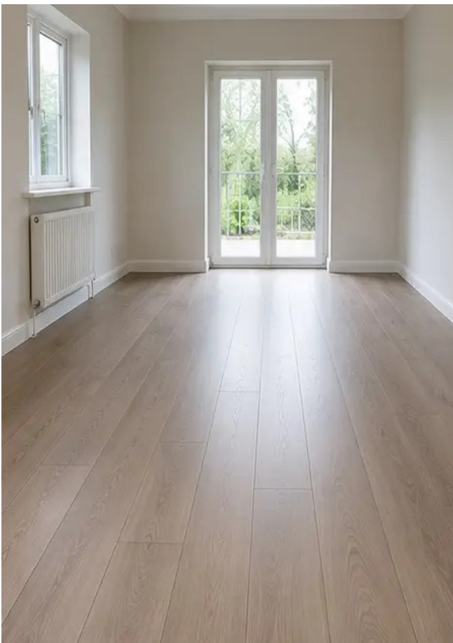
Foto №6 Staat van de vloer na de vervanging
