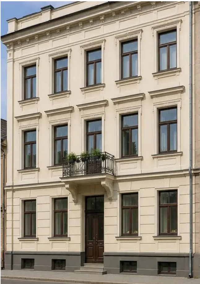
Foto №14 Gevel van het gebouw na de restauratiewerkzaamheden
