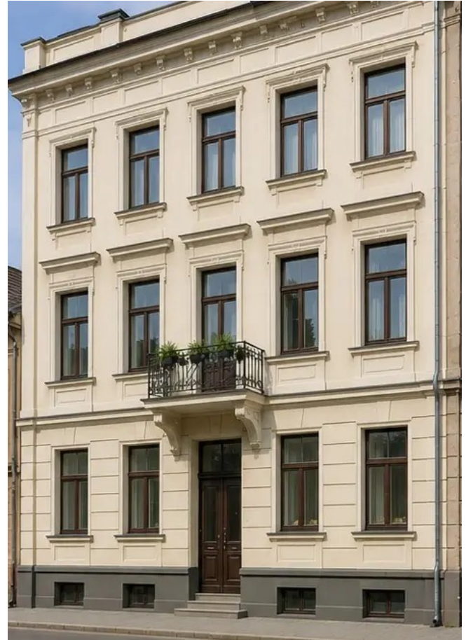
Foto №14 Gevel van het gebouw na de restauratiewerkzaamheden
