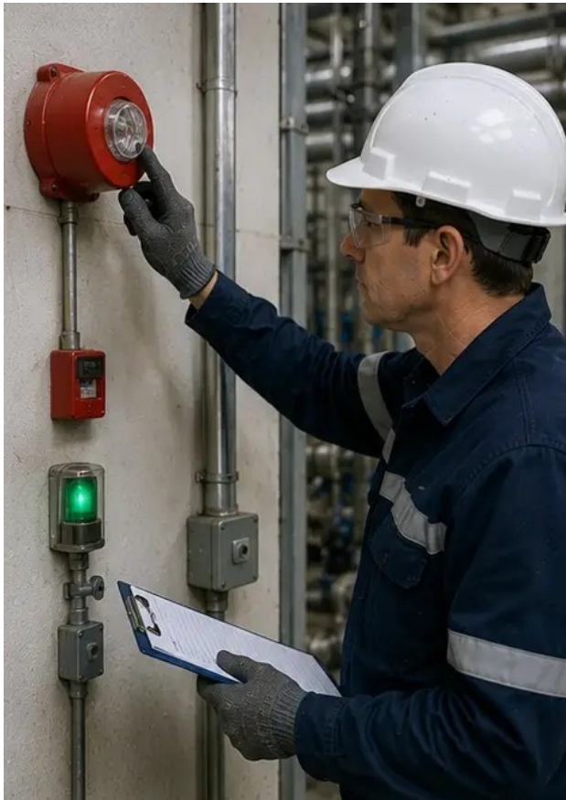
Foto №13. Inspectie van het veiligheidssysteem voltooid
