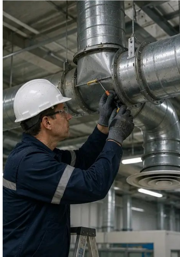
Foto №8. Onderhoud aan het ventilatiesysteem voltooid
