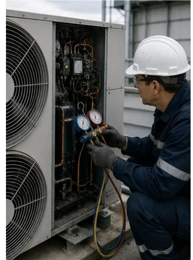
Foto №6. Staat van de HVAC-apparatuur gedocumenteerd
