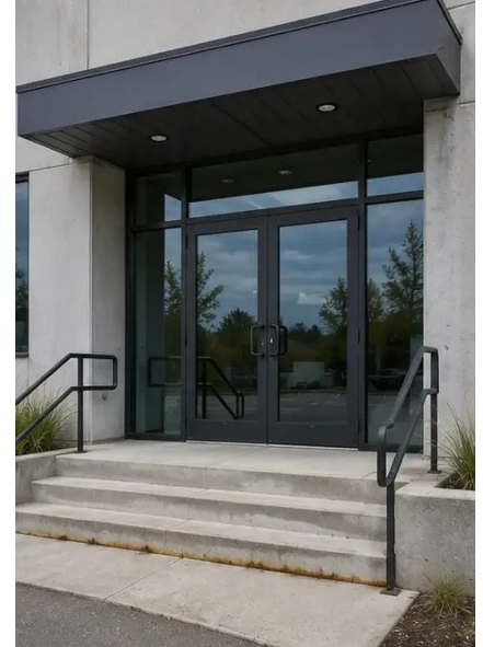
Photo #3. Hoofdingang geïnspecteerd en gedocumenteerd
