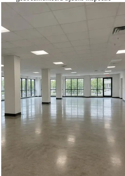
Photo #16. Eindoverzicht van het geïnspecteerde pand
