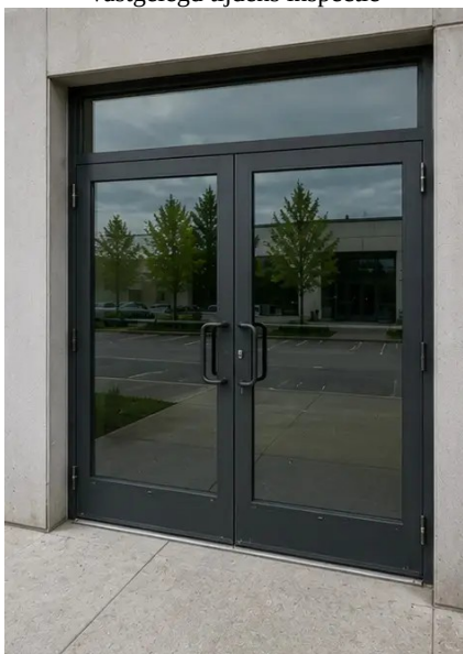
Photo #7. Staat van de deuren geïnspecteerd en geregistreerd
