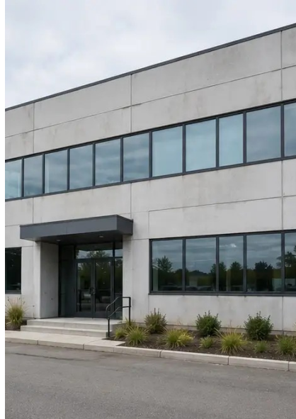
Photo #2. Staat van de voorgevel tijdens de inspectie
