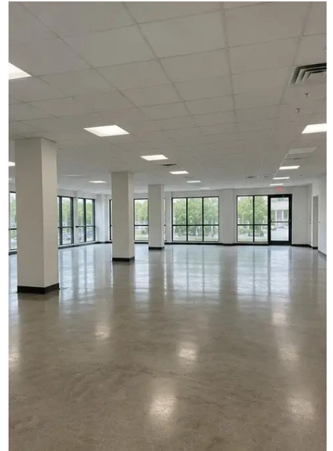
Photo #16. Eindoverzicht van het geïnspecteerde pand
