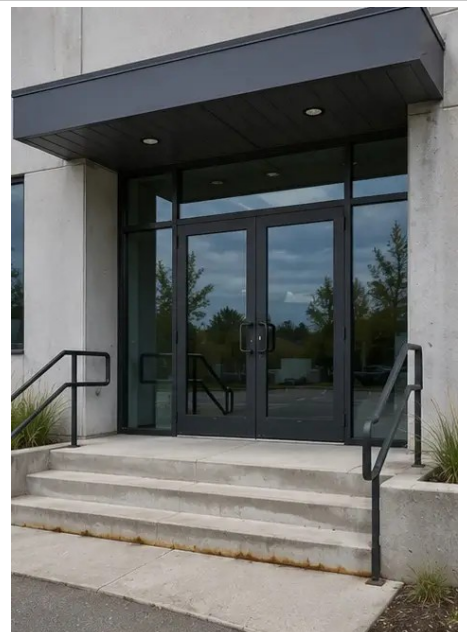
Photo #3. Hoofdingang geïnspecteerd en gedocumenteerd
