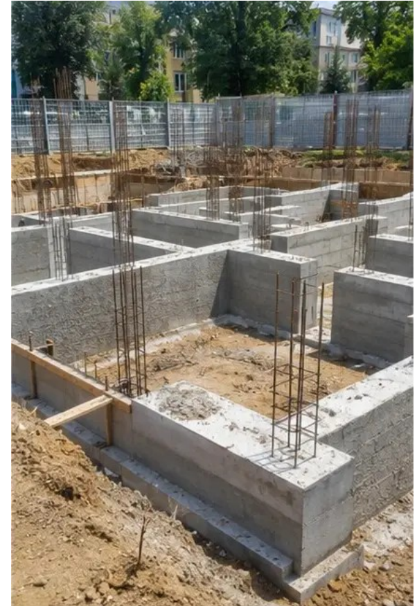
Foto №3 Fundering in uitvoering
