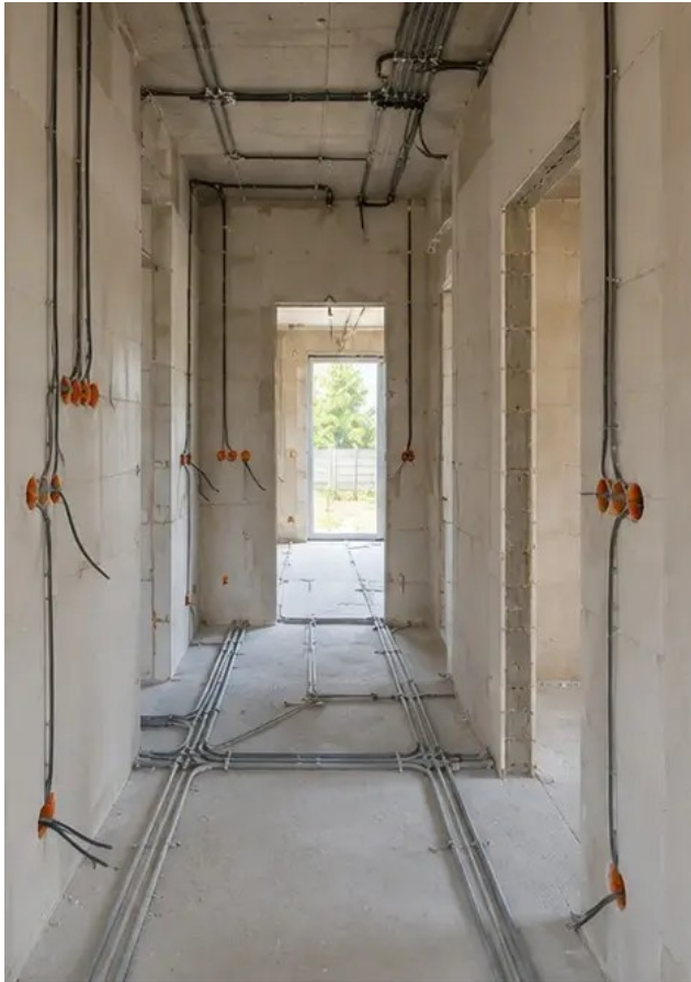
Foto №9 Installatie van elektrische systemen in uitvoering
