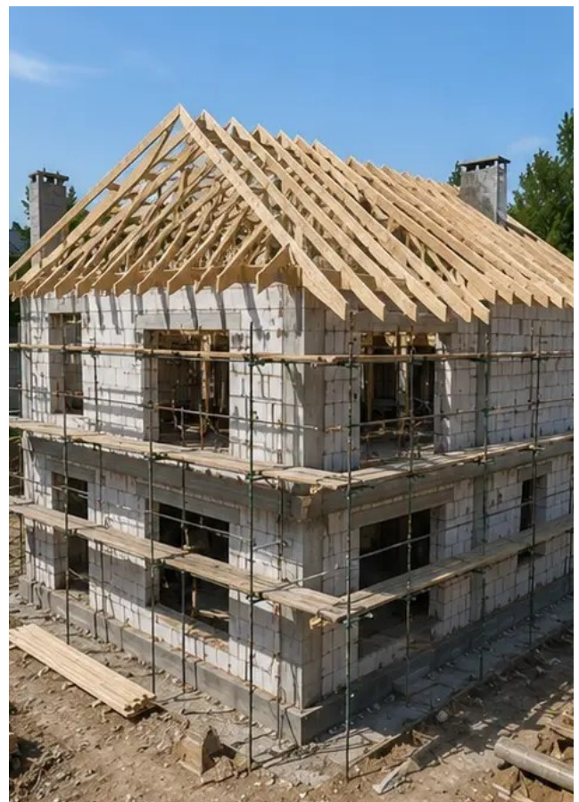
Foto №8 Dakinstallatiewerkzaamheden afgerond
