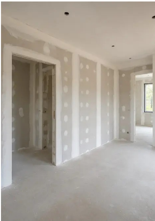
Foto №11 Afwerking binnenmuren in uitvoering
