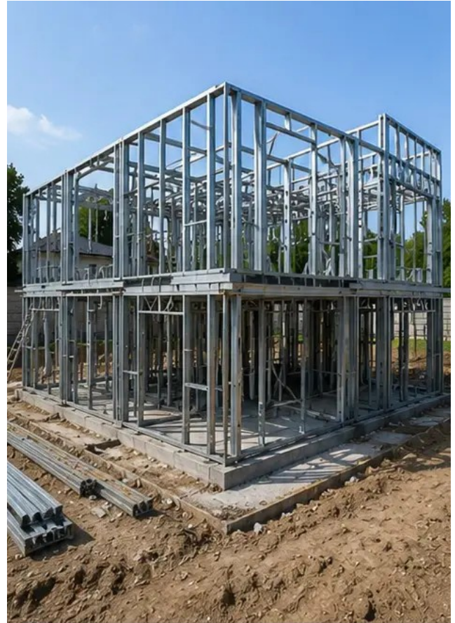
Foto №6 Montage van het draagframe in uitvoering
