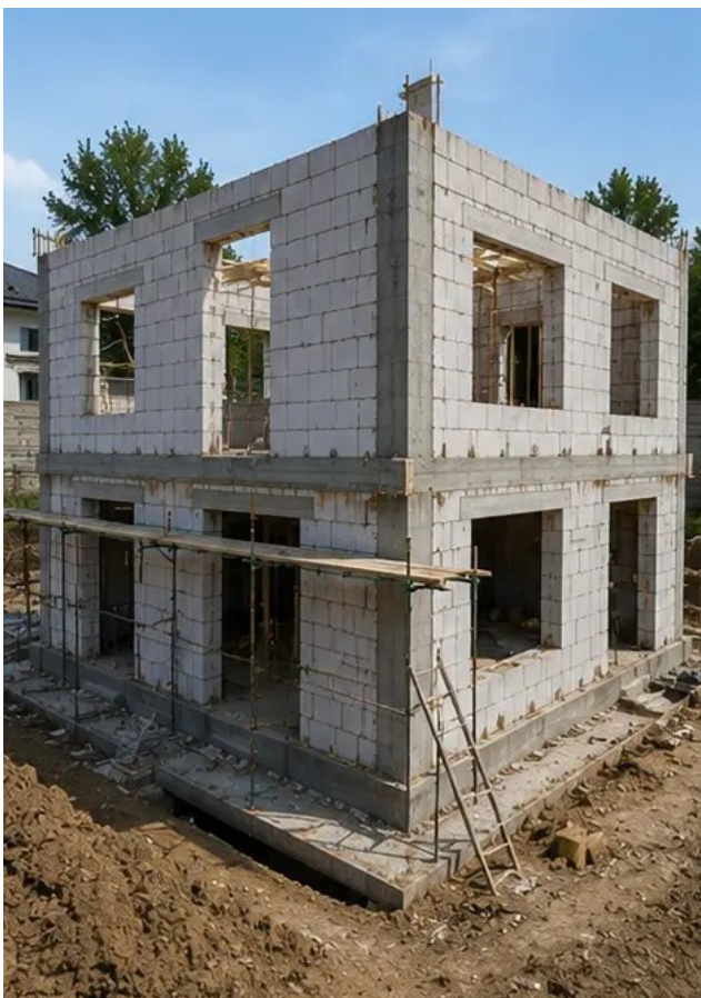
Foto №7 Buitenmuurconstructie voltooid voor het bouwdeel
