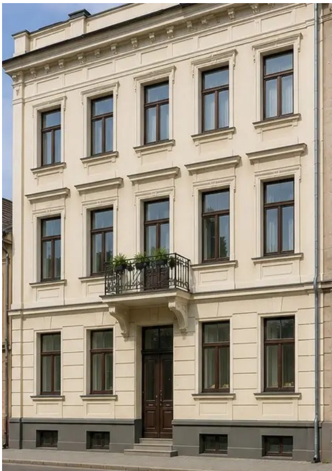
Foto №14 Fasad bangunan selepas kerja pemulihan
