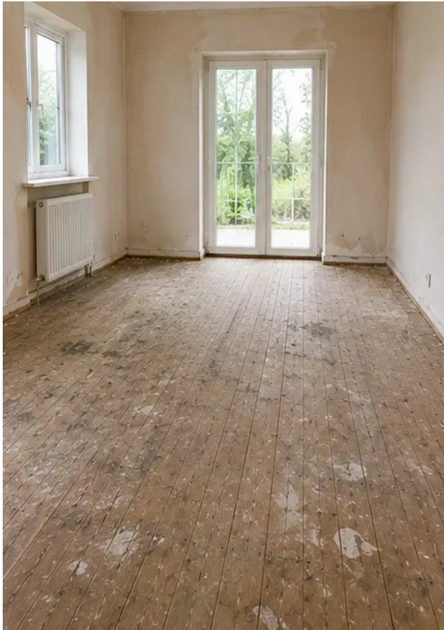
Foto №5 Keadaan lantai sebelum penggantian
