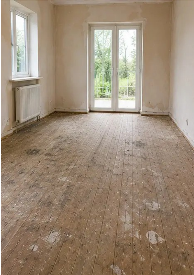
Foto №5 Keadaan lantai sebelum penggantian
