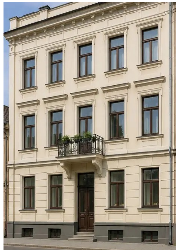
Foto №14 Fasad bangunan selepas kerja pemuliharaan
