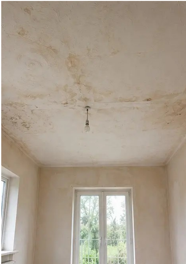
Foto No7 Keadaan siling sebelum pengubahsuaian
