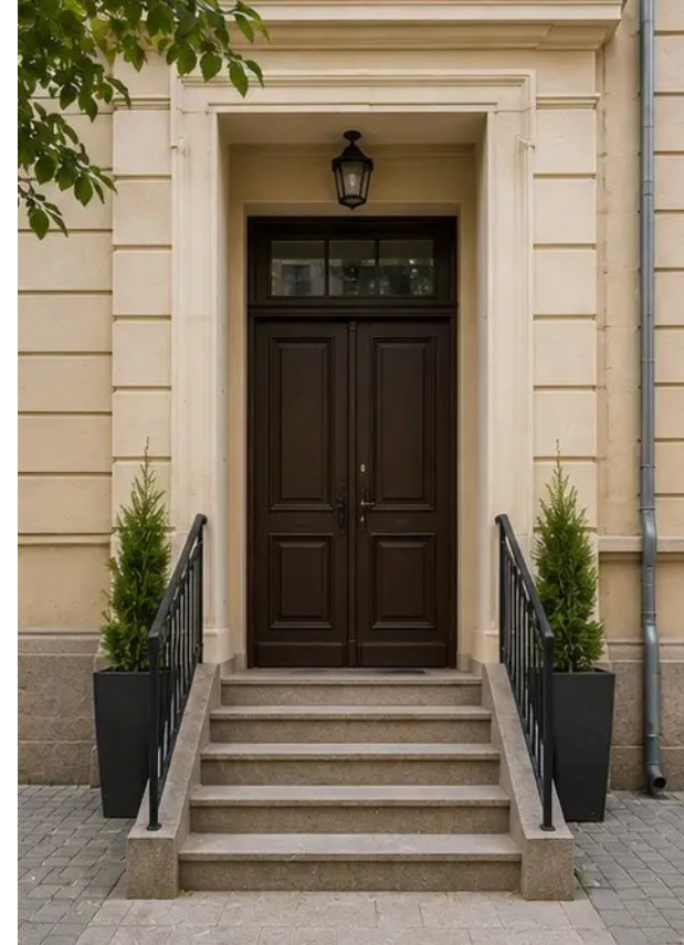
Foto №16 Pintu masuk hartanah selepas penambahbaikan
