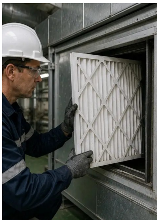
Foto №7. Penggantian penapis udara selesai
