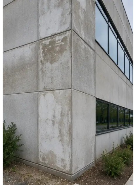
Photo #4. Keadaan dinding luar direkodkan semasa pemeriksaan
