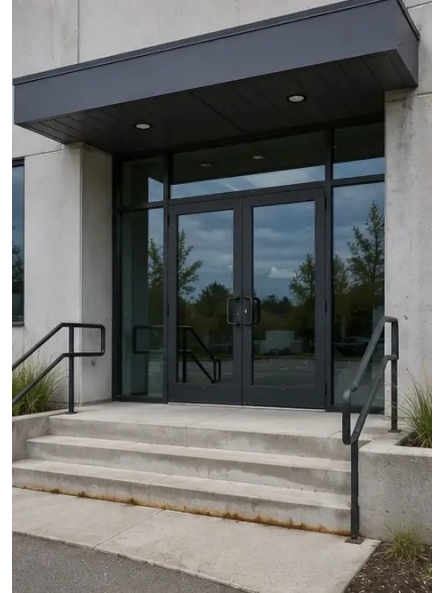
Photo #3. Kawasan pintu masuk utama diperiksa dan didokumenkan
