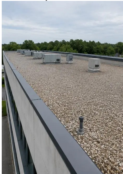
Photo #5. Pemeriksaan keadaan bumbung selesai
