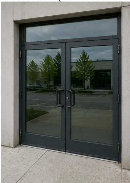
Photo #7. Keadaan pintu diperiksa dan direkodkan
