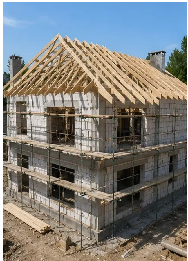
Foto №8 Kerja pemasangan bumbung selesai
