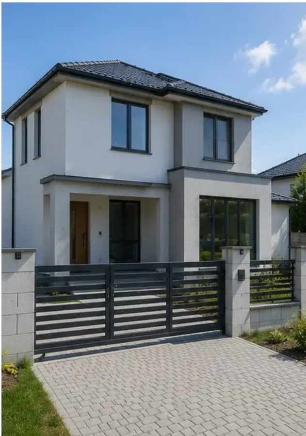
Foto №15 Bahagian luar bangunan yang siap selepas pembinaan
