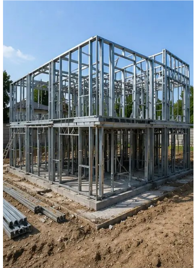
Foto №6 Pemasangan kerangka struktur sedang berjalan
