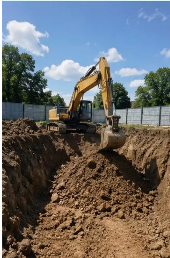
Foto №2 Kerja penggalian dilaksanakan mengikut keperluan projek
