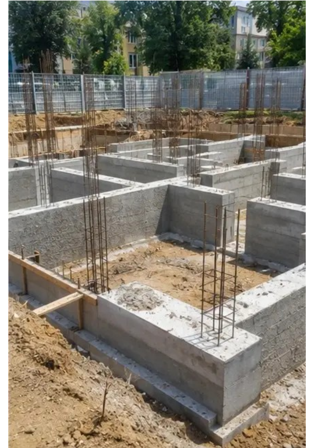
Foto №3 Pembinaan asas sedang berjalan
