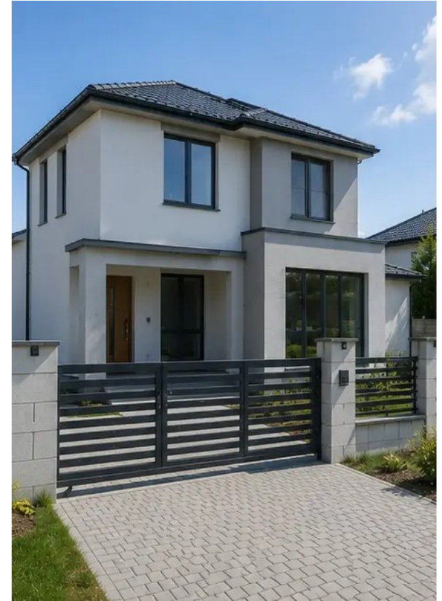
Foto №15 Bahagian luar bangunan yang siap selepas pembinaan
