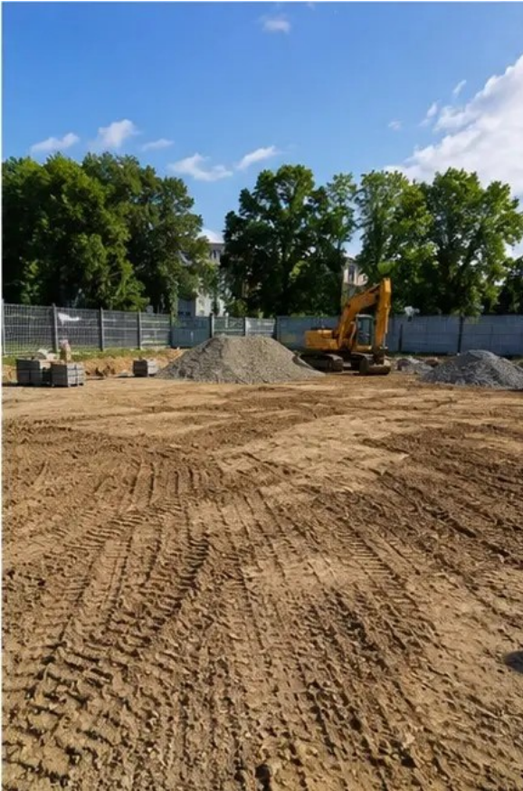
Foto №1 Kerja penyediaan tapak selesai sebelum permulaan pembinaan
