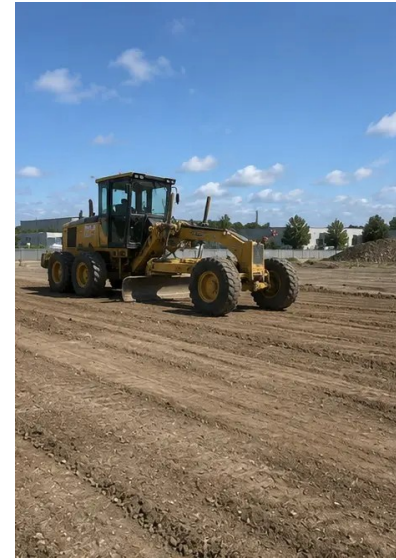
Foto №3. Pembersihan dan perataan tanah selesai
