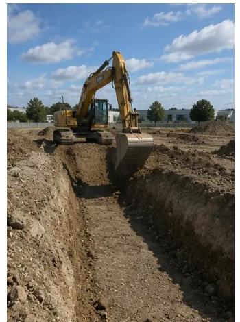
Foto №4. Kerja penggalian awal selesai
