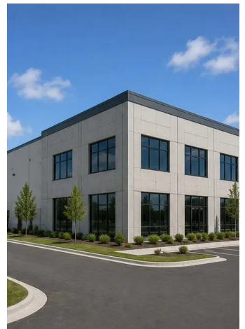
Foto №16. Projek yang telah siap sedia untuk beroperasi
