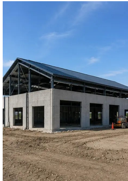
写真 №14. 機器設置完了
