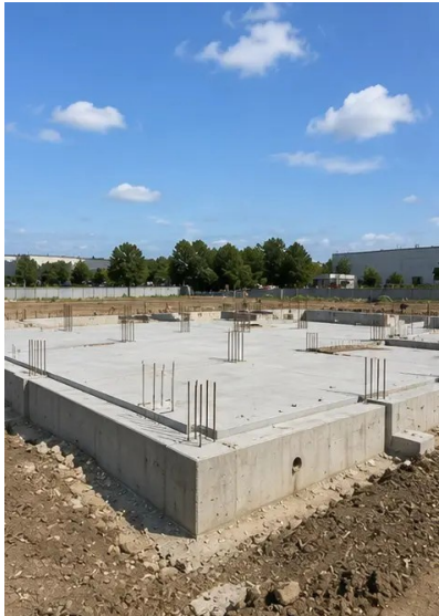
写真 №5. 基礎工事完了
