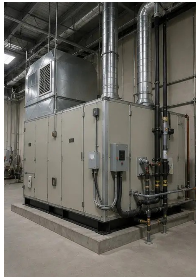
写真 №14. 機器設置完了
