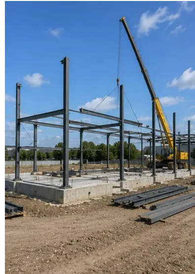
写真 №6. 構造フレーム組立開始
