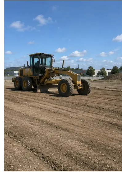
写真 №3. 地盤整地と整地完了
