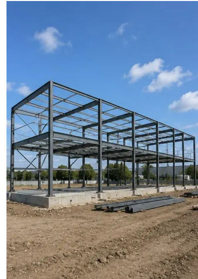
写真 №7. 構造フレーム建設進行中
