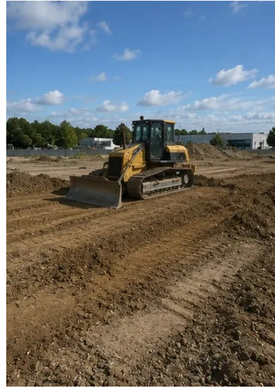
写真 №2. 現場準備作業進行中
