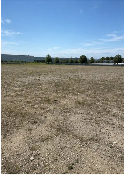
写真 №1. 工事開始前のプロジェクト現場
