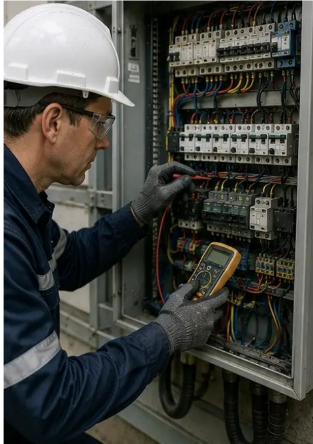
写真 №5. 電気キャビネットの点検実施
