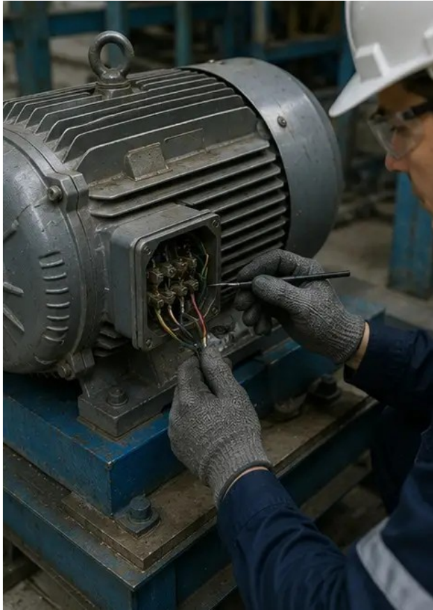
写真 №4. 電動機の点検完了
