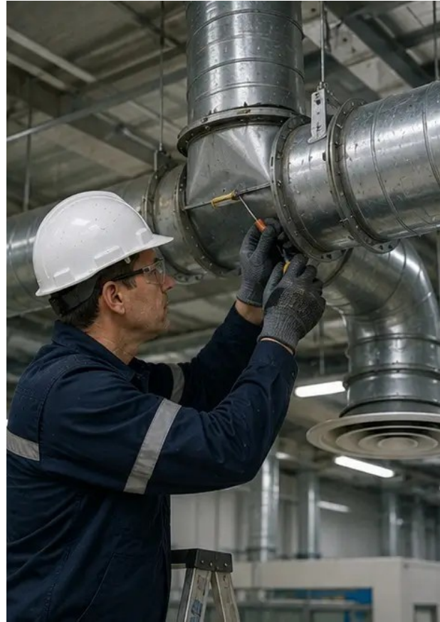
写真 №8. 換気システムのメンテナンス完了
