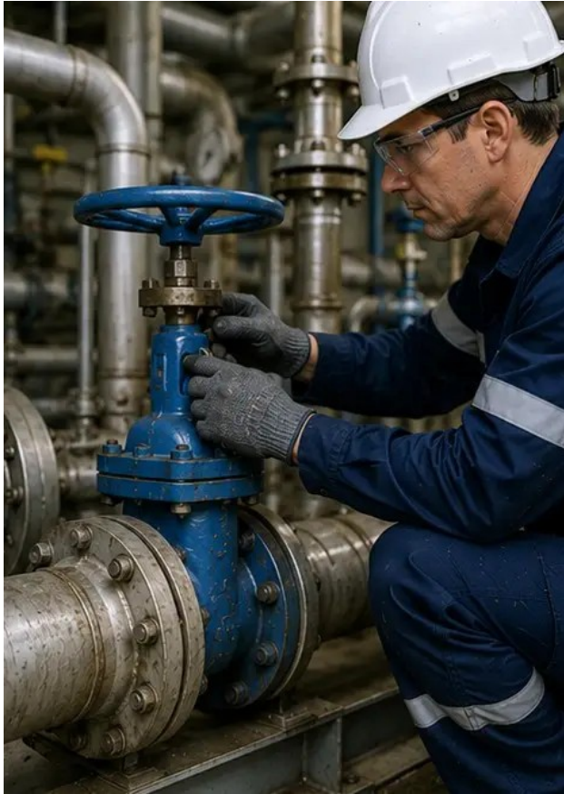
写真 №10. 点検中に評価されたバルブの状態
