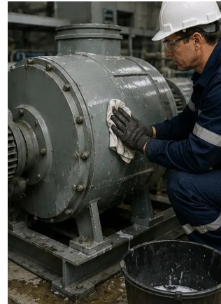
写真 №12. 機器清掃手順完了
