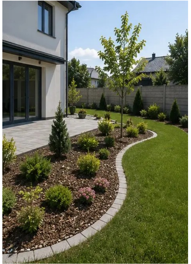
写真 №14 施設周辺の外構工事完了
