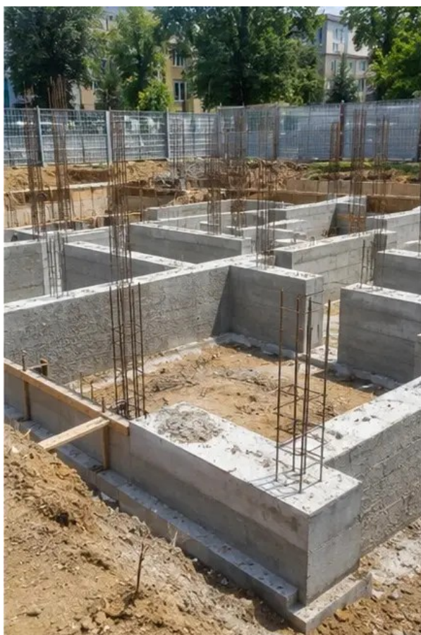
写真 №3 基礎工事進行中
