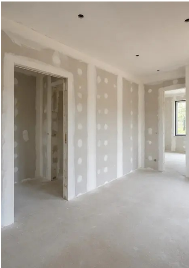
写真 №11 内壁仕上げ工事進行中
