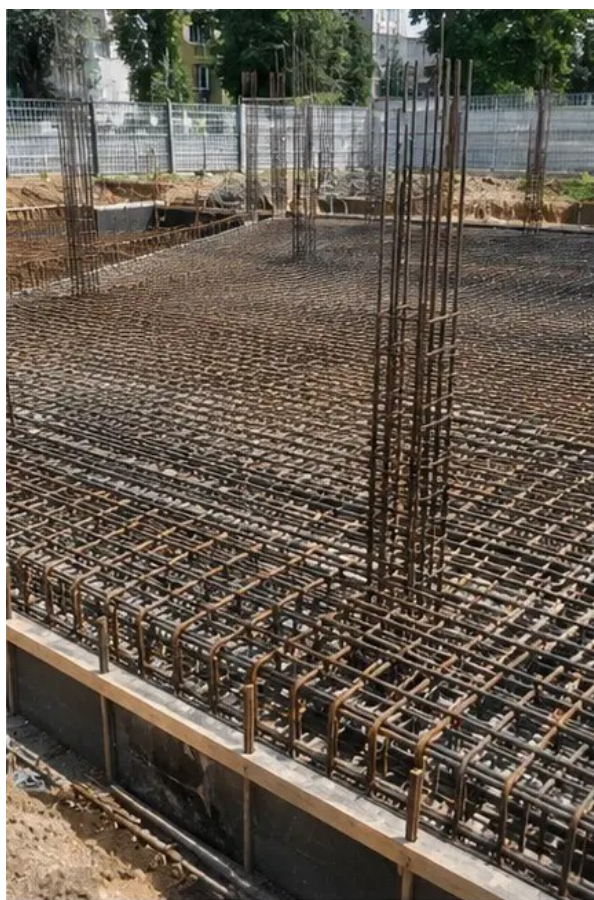
写真 №4 コンクリート打設前の鉄筋設置完了
