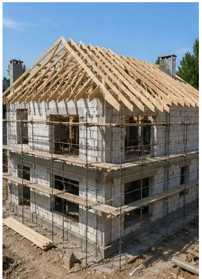
写真 №8 屋根設置工事了
