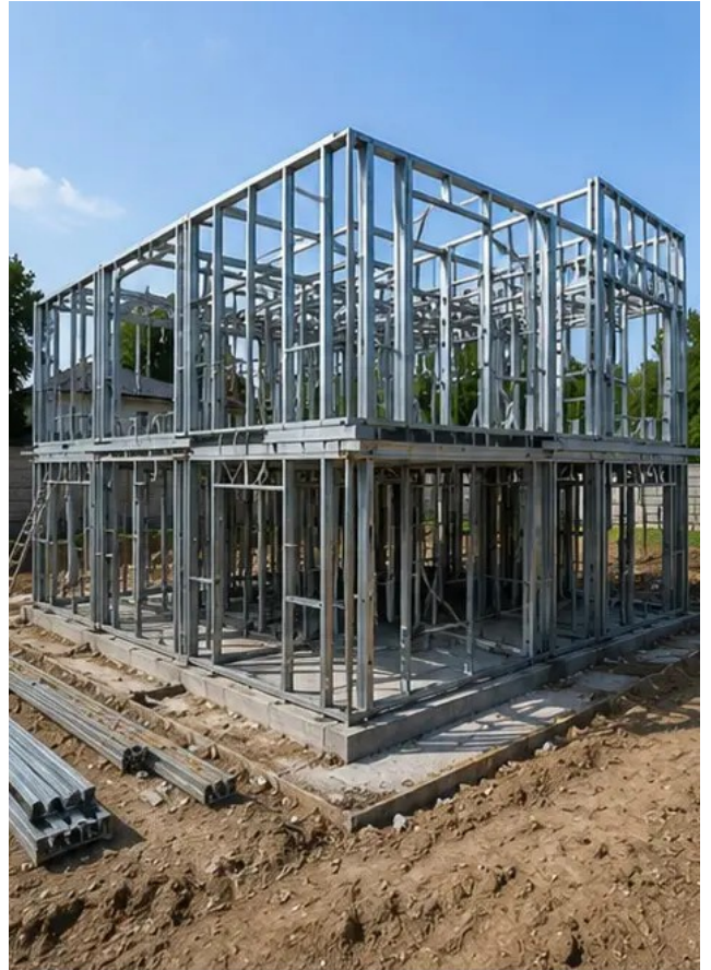
写真 №6 構造フレーム組立進行中
