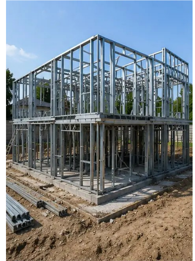
写真 №6 構造フレーム組立進行中
