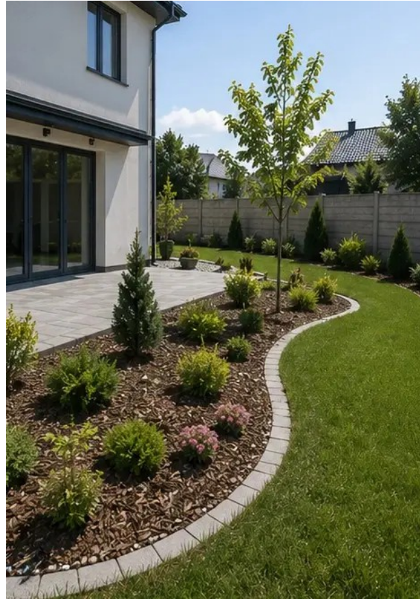
写真 №14 施設周辺の外構工事完了
