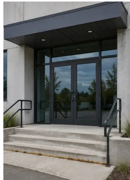
Photo #3. 調査し記録した正面玄関エリア
