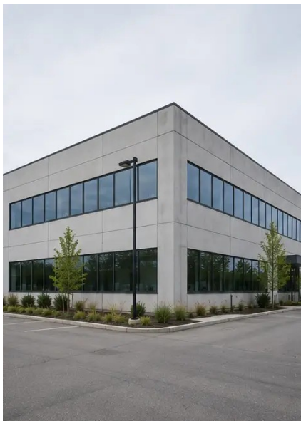
Photo #1. 調査した物件の全体像
