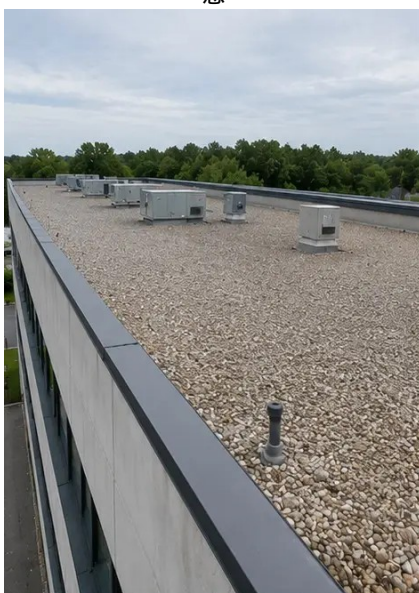
Photo #5. 屋根の状態調査完了
