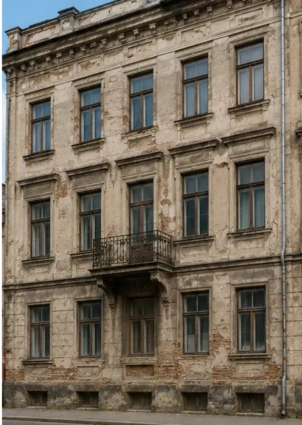
写真 №13 修復工事前の建物ファサード
