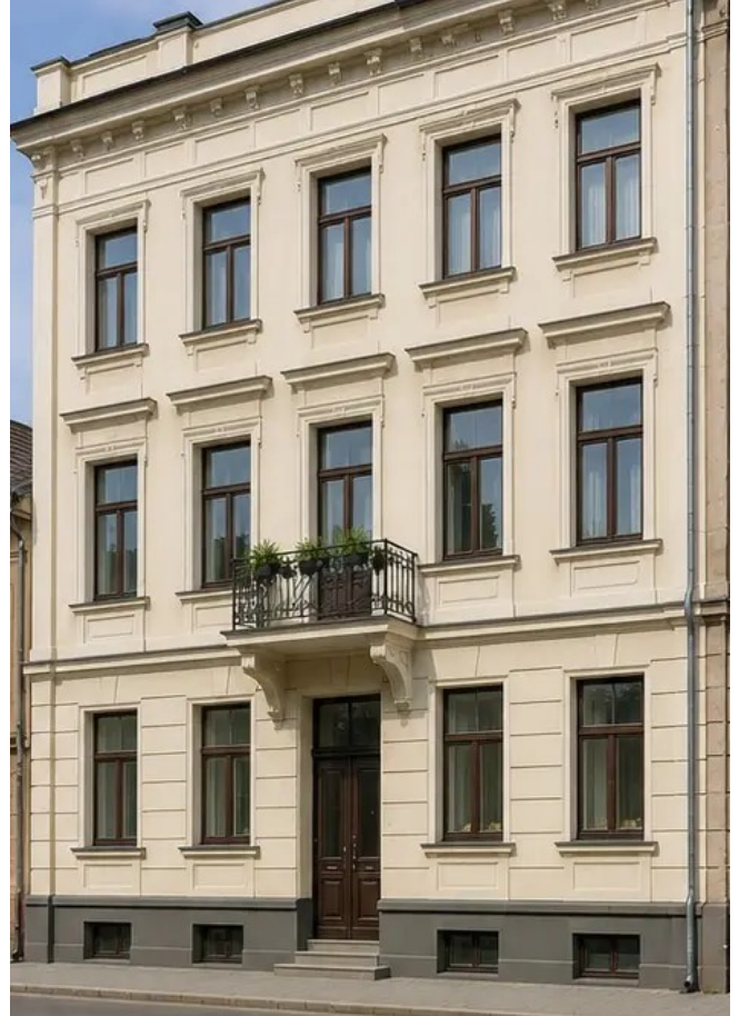
写真 №14 修復工事後の建物ファサード
