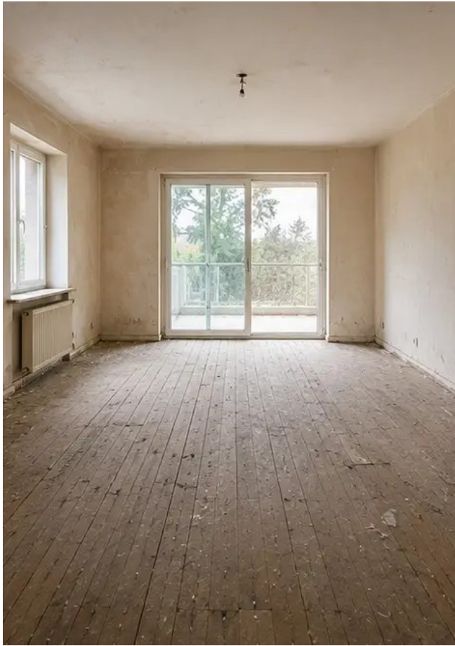
写真 №1 リノベーション前のリビングルームの状態
