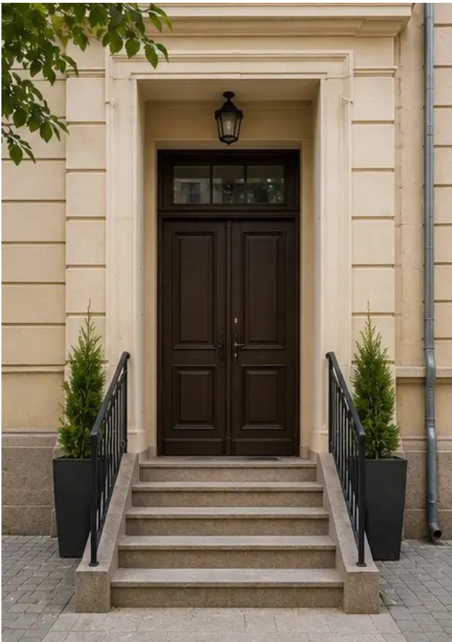
写真 №16 改善後の物件入口
