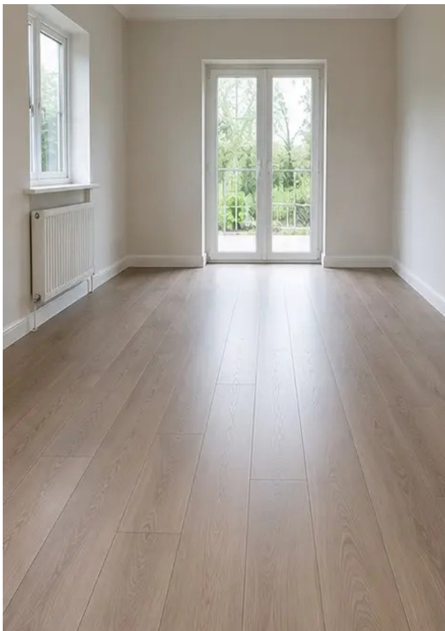
写真 №6 交換後の床の状態
