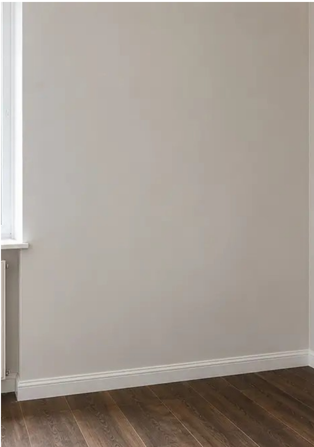
写真 №4 補修工事後の壁の状態
