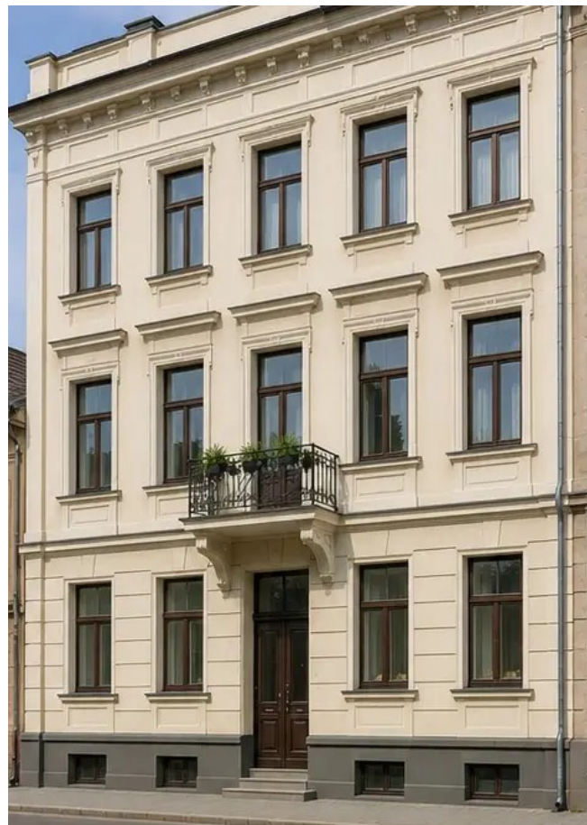
Foto №14 Facciata dell'edificio dopo i lavori di restauro
