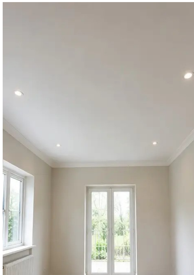
Foto №8 Stato del soffitto dopo la ristrutturazione
