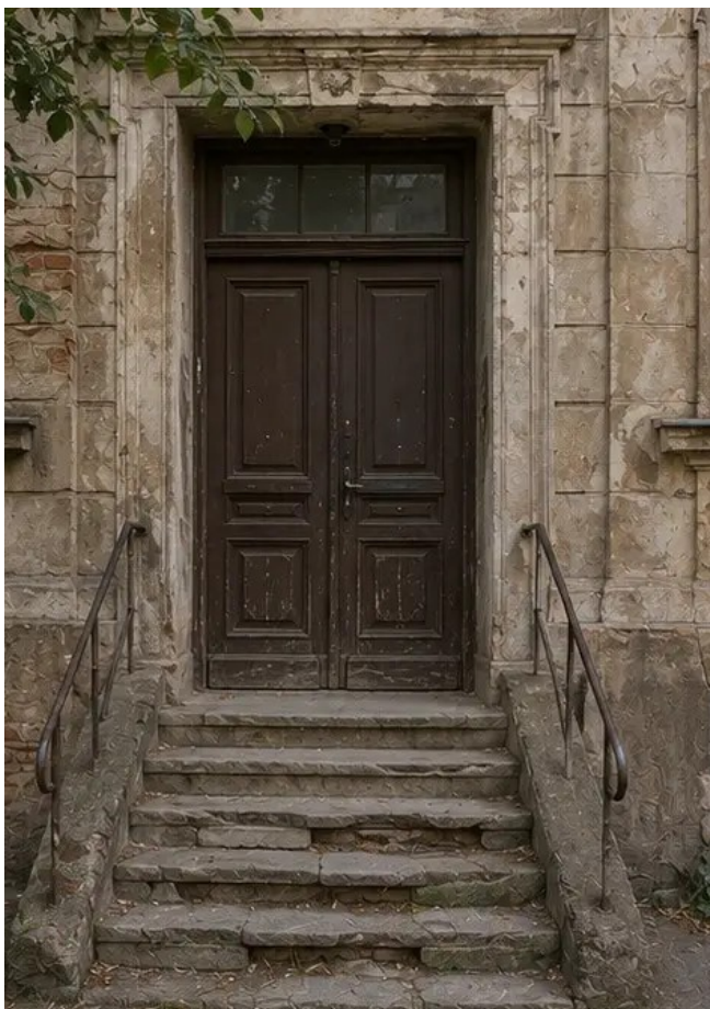
Foto №15 Ingresso della proprietà prima del miglioramento
