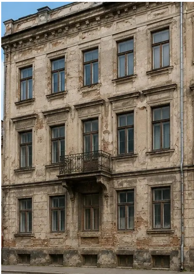
Foto №13 Facciata dell'edificio prima dei lavori di restauro
